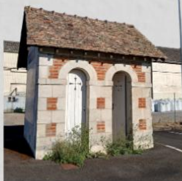
Uniques vestiges de l'ancienne gare : les toilettes.
